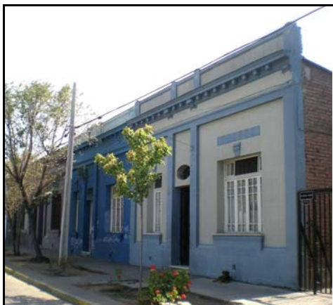
Fotografía de fachada
