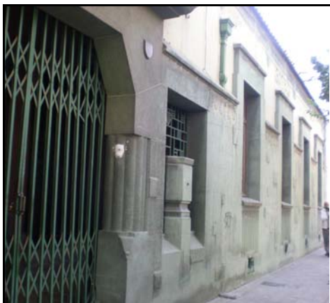
Fotografía de fachada
