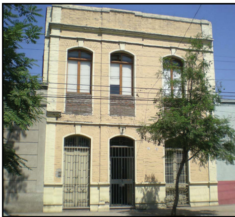
Fotografía de fachada
