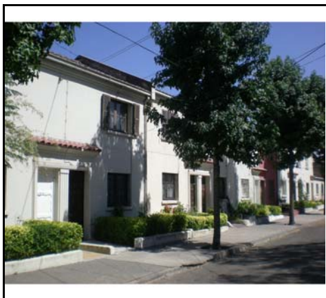
Fotografía de fachada
