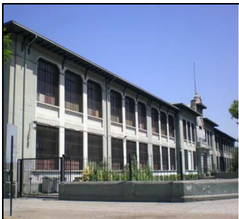
Fotografía de fachada
