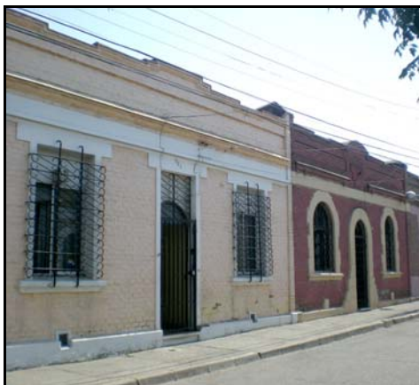
Fotografía de fachada
