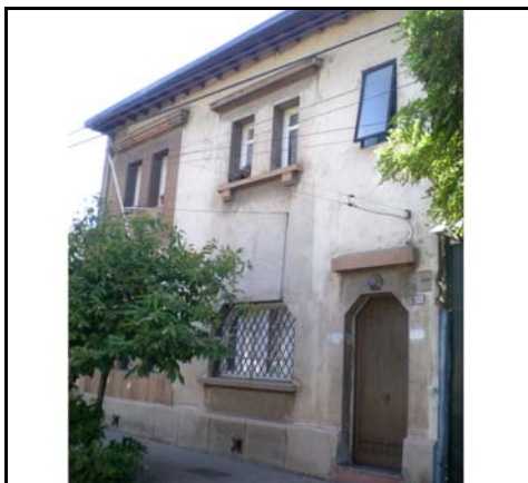
Fotografía de fachada
