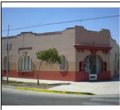
Fotografía de fachada
