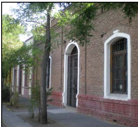
Fotografía de fachada
