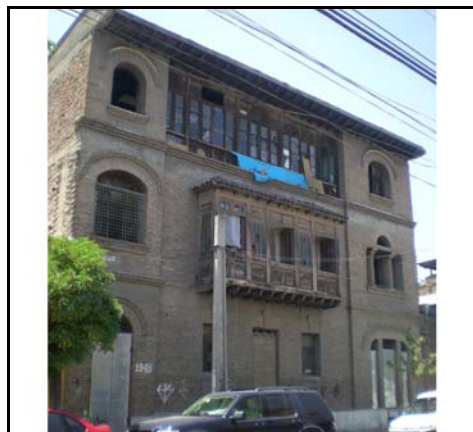
Fotografía de fachada
