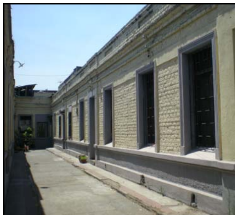
Fotografía de fachada
