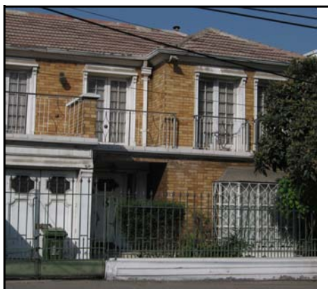
Fotografía de fachada
