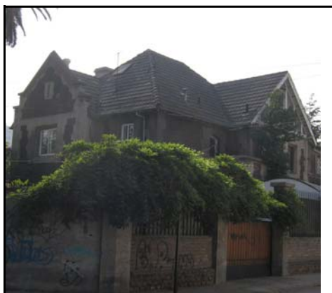
Fotografía de fachada
