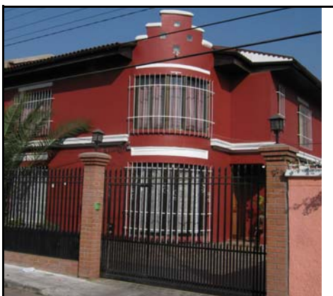
Fotografía de fachada
