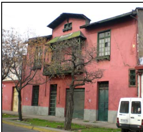
Fotografía de fachada
