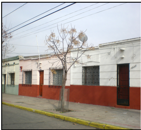
Fotografía de fachada
