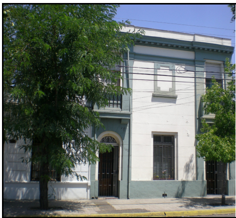
Fotografía de fachada
