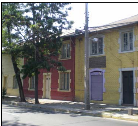
Fotografía de fachada
