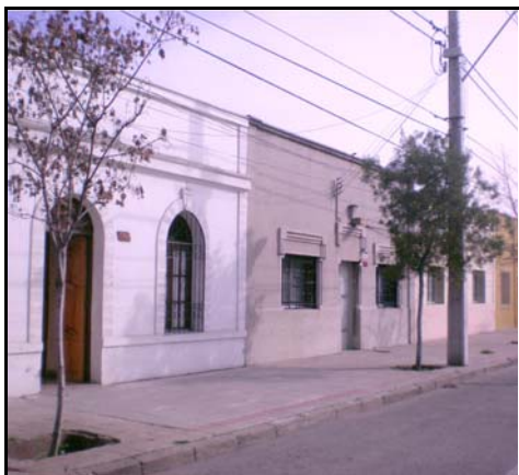
Fotografía de fachada
