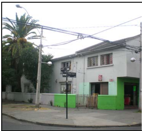
Fotografía de fachada
