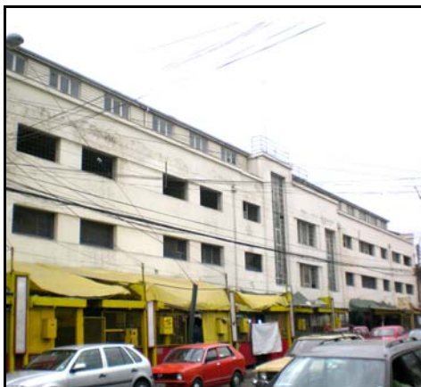
Fotografía de fachada
