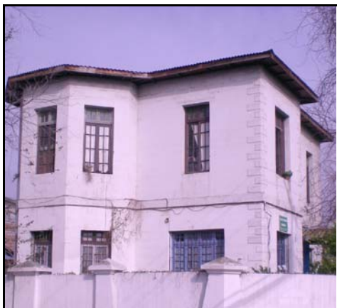
Fotografía de fachada
