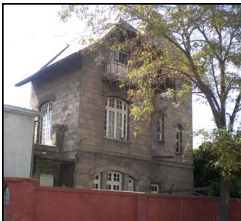
Fotografía de fachada
