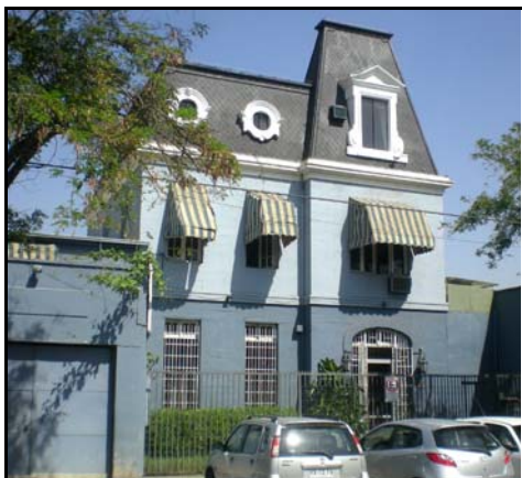
Fotografía de fachada
