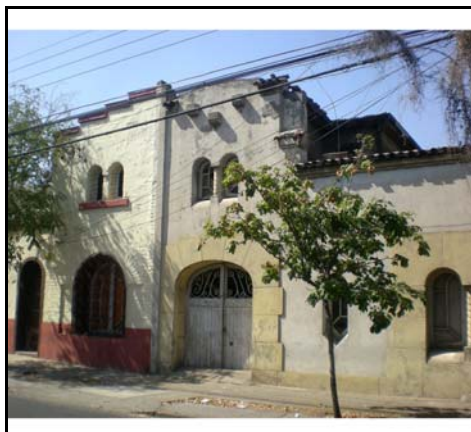
Fotografía de fachada
