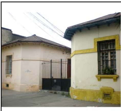
Fotografía de fachada
