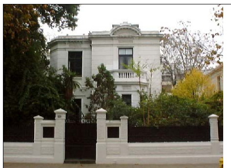
Fotografía de fachada
