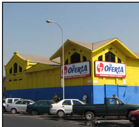
Fotografía de fachada
