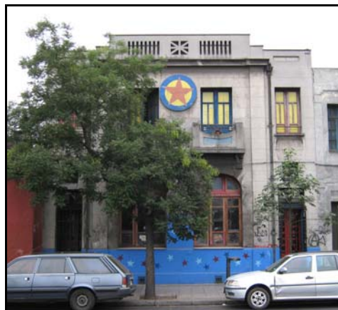
Fotografía de fachada
