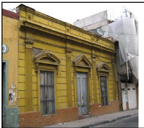
Fotografía de fachada
