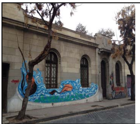
Fotografía de fachada
