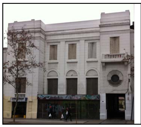
Fotografía de fachada
