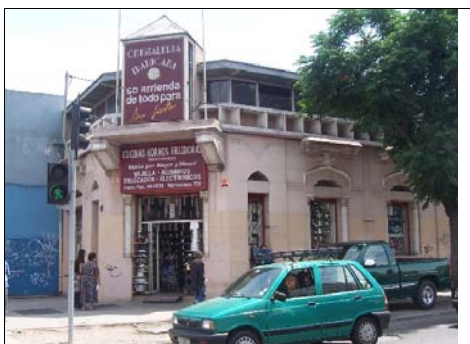
Fotografía de fachada
