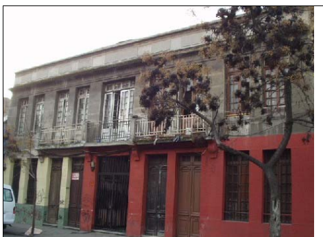
Fotografía de fachada
