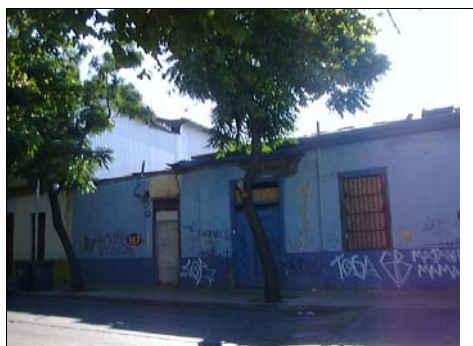
Fotografía de fachada
