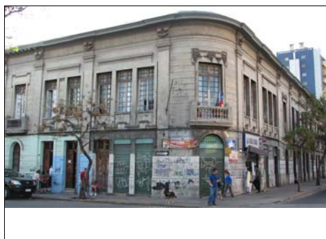
Fotografía de fachada
