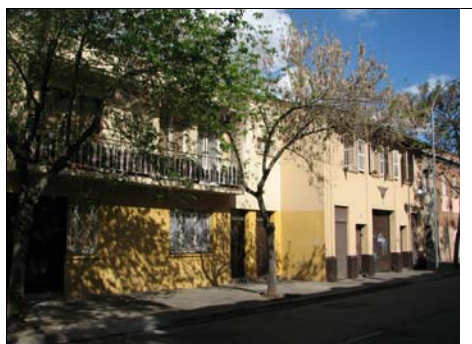
Fotografía de fachada
