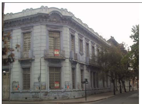
Fotografía de fachada
