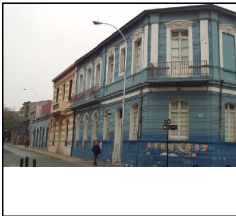
Fotografía de fachada
