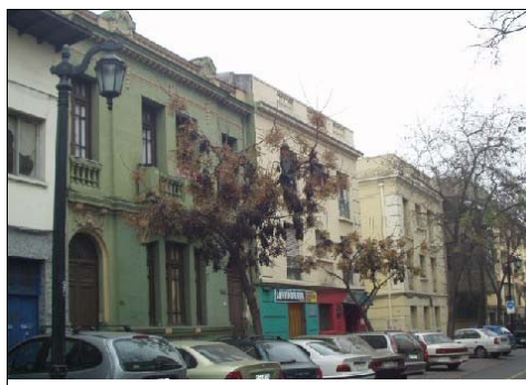
Fotografía de fachada
