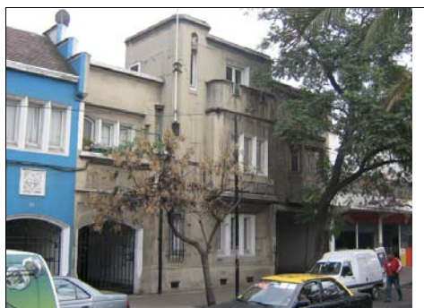
Fotografía de fachada
