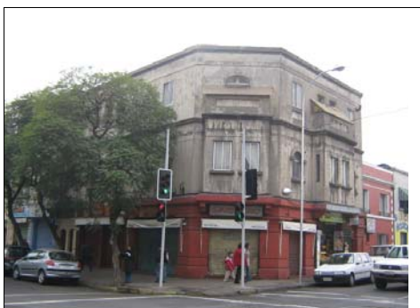
Fotografía de fachada
