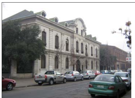
Fotografía de fachada
