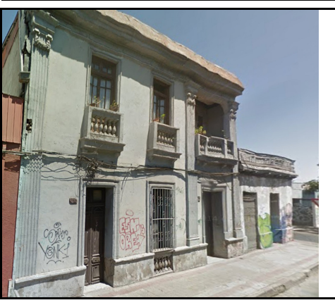
Fotografía de fachada
