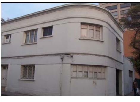
Fotografía de fachada
