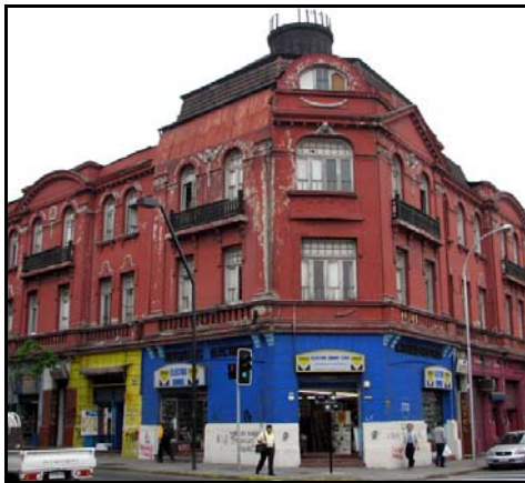
Fotografía de fachada
