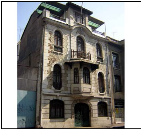
Fotografía de fachada
