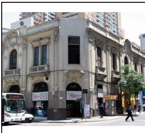
Fotografía de fachada
