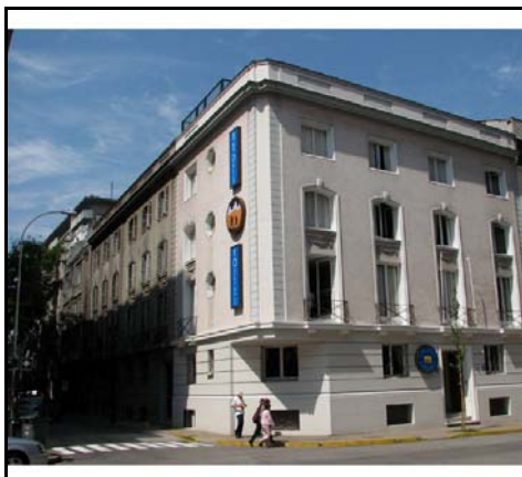
Fotografía de fachada
