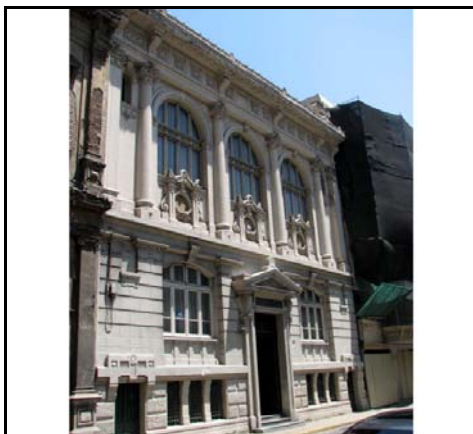
Fotografía de fachada
